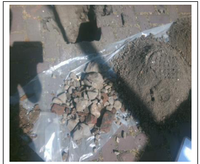
Foto 22. Asbestinspectiegat C07 25-50 cm-mv
