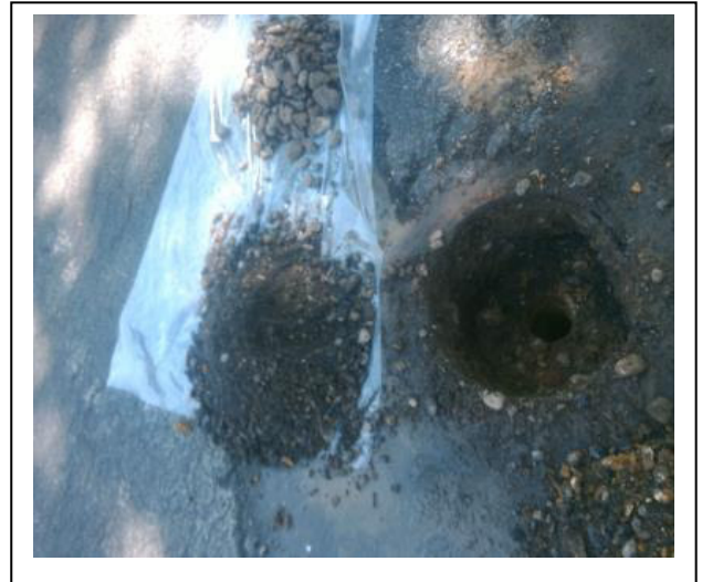
Foto 8. Asbestinspectiegat B10 3-50 cm-mv
